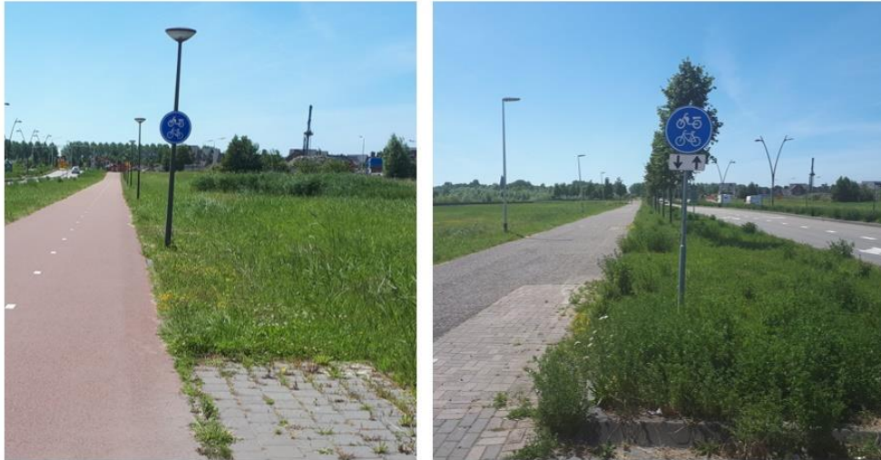
Afbeelding 1 en 2: Fiets-/bromfietspad aan de noordzijde (links) en zuidzijde (rechts)
