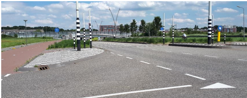
Afbeelding 22: Zicht vanaf de Sportlaan op verkeer uit de tunnelbak.
